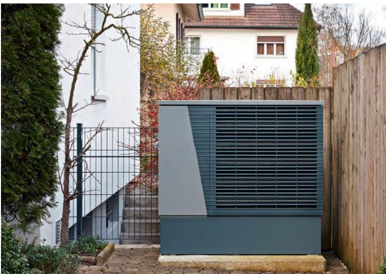
Bild: Aussen aufgestellte Luft/Wasser-Wärmepumpe (zvg)
